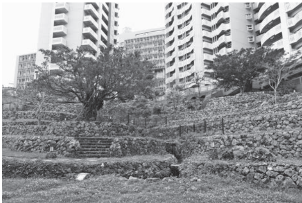
図③-1 室川市営住宅石積み
