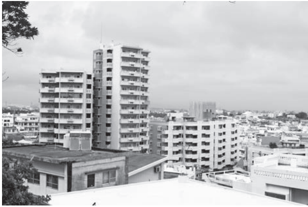
図② 室川市営住宅遠景
