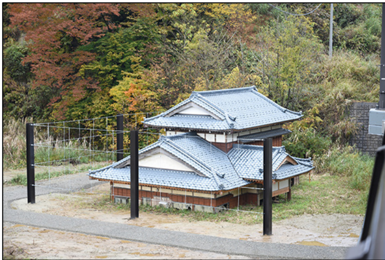
図 3-29：河道閉塞により水没した家屋 木籠メモリアルパーク
